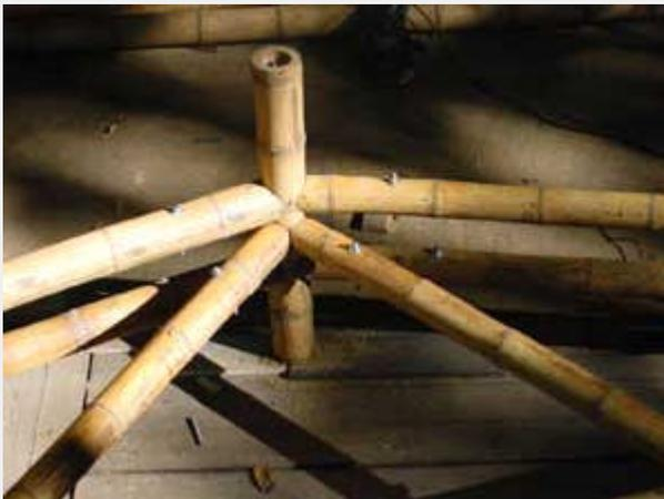
Die Konstruktion besteht aus 400 Guadua Angustifolia-Bambushalmen. Zur Verbesserung der Haltbarkeit wurde diese in Pereira, Kolumbien, durch das Räucherverfahren zusätzlich imprägniert. Durch die verschiedenen Dachflächen und die völlig offene Konstruktion entsteht ein leichter und transparenter Eindruck.
