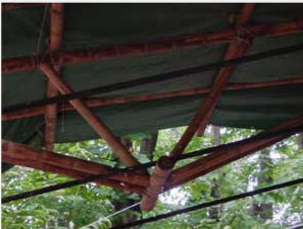
Die Stützen sind hauptsächlich auf Druckkraft belastet. Sie sind jeweils aufgeteilt in drei einzelne Bambushalme, von denen zwei V-förmig angeordnet sind, um so für eine ausreichende Windaussteifung zu sorgen. Der Fachwerbinder ist so ausgebildet, dass ein großer Dachüberstand entsteht, welcher für den Holzschutz notwendig ist.
