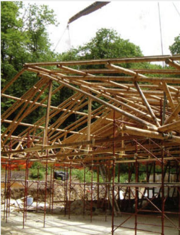
Bei der Errichtung des Pavillon wurde zunächst das Dach auf einem Gerüst errichtet, welches später durch die Bambusstützen ersetzt wurde.
