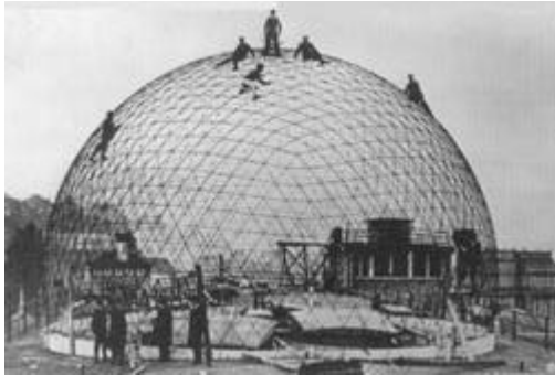
Bewehrung für eine Stahlbetonkuppel
