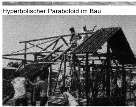
Low-cost Prototyp-Wohnhaus aus Bambus in Ekuador
