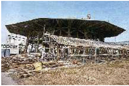
Zeri-Pavillon während der Bauphase
