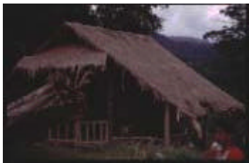
Dach, reine Bambuskonstruktion, nahe Chiang Rai
