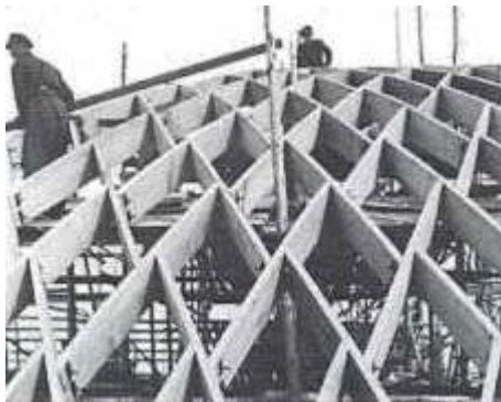
Zollbauweise während der Herstellung
